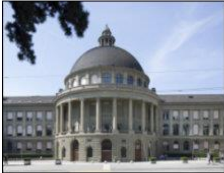
Das ETH-Gebäude in Zürich. (Bild: Keystone/Gaetan Bally)
