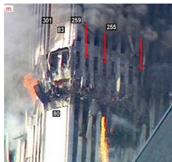
Aus WTC 2 strömendes flüssiges Metall
