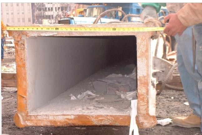
*Diese massiven Stahlträger waren, wie oben bereits beschrieben, alle einem Meter nebeneinander angeordnet. Sie gehörten zur Außenstruktur*
